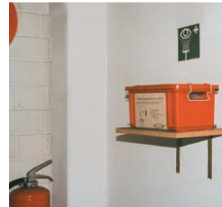
Bild 9-1: Augenspülflasche, gegen Feuchtigkeit, Schmutz, Beschädigung geschützt und leicht zugänglich
